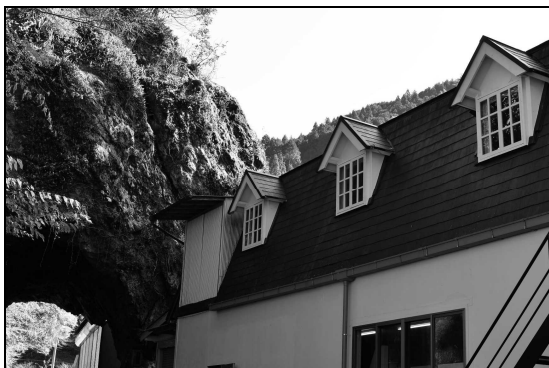
写真-1 工場外観
