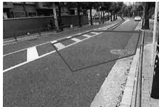
写真-1 道路面の大型人孔の位置
