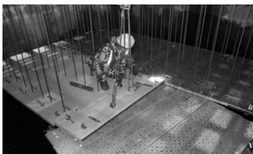
写真-2 残存型枠と吊りボルトの接合状況
