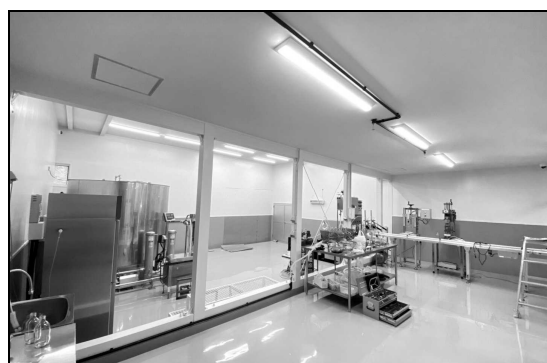
写真-2 工事完成後の施設内
