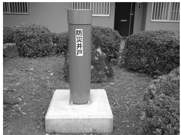
写真-4 防災井戸
